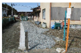
西面・縁石完成♪♪♪
